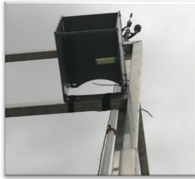
Figura 9. Captador passiu instal·lat a la Unitat Mòbil
