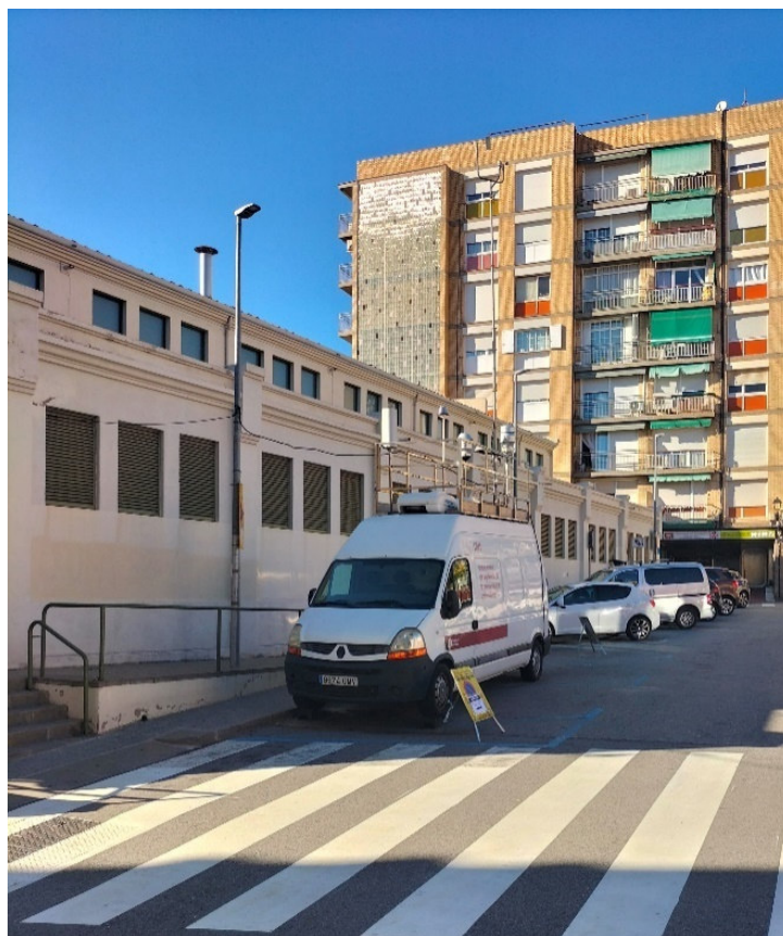
Emplaçament de la Unitat Mòbil 1 (Mercat municipal)
