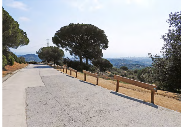
Elements de seguretat instal·lats a l'accés al Bosc d'en Vilaró. Font: Arxiu XPN
