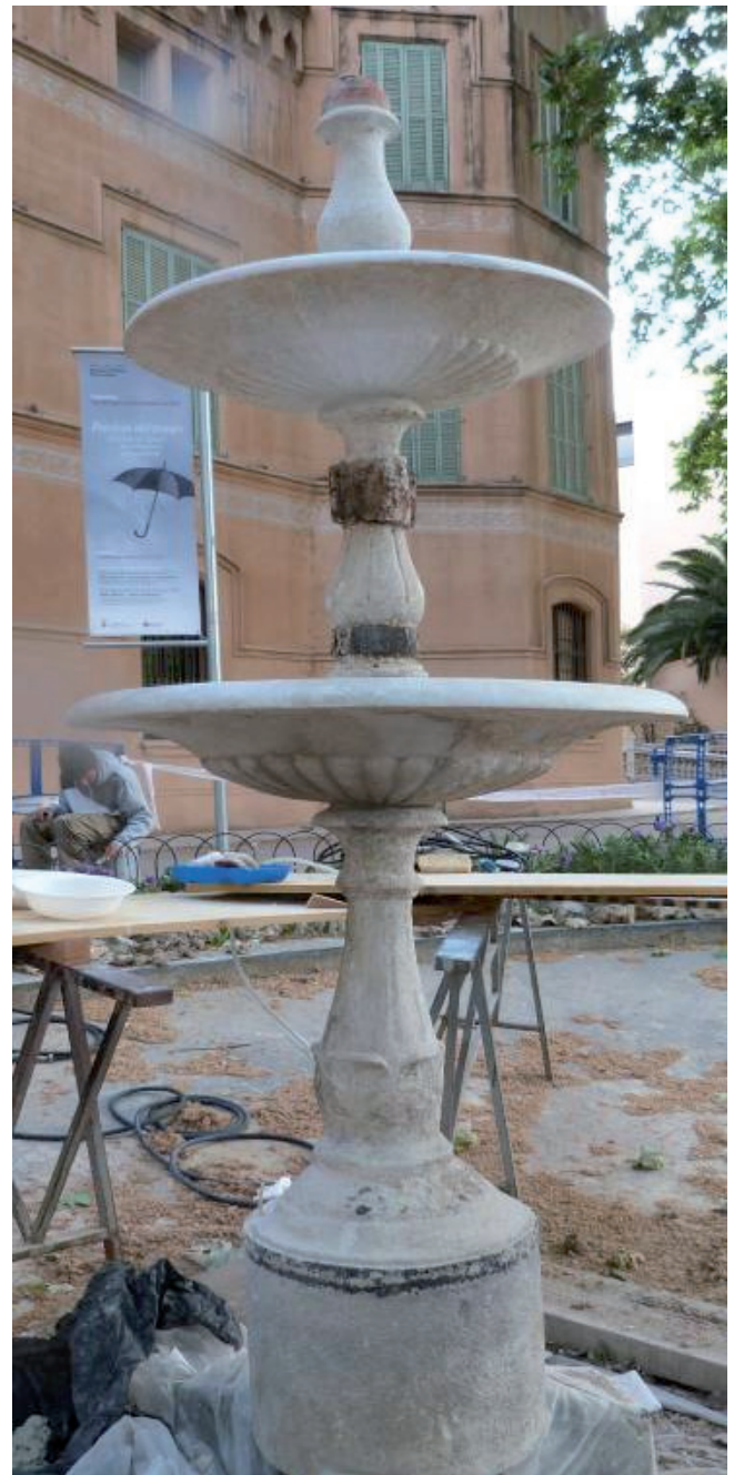
Figura 10. La fuente del Palau Mercader después de la 1ª fase de intervención
