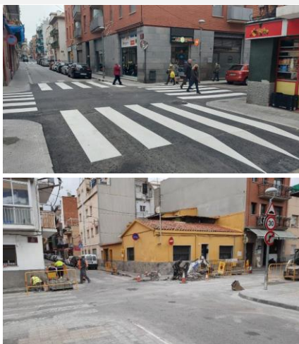
Exemples d'obres de millora d'accessibilitat a la Barriada Nova
