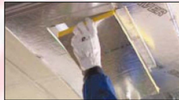
Puerta de registro.
