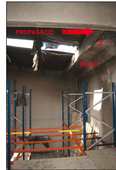
Foto 2: Vista interior inutilització franja tallafocs
