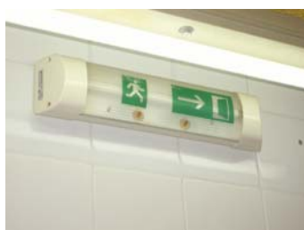
Supervisió visual de l'estat de l'enllumenat d'emergència i les lluminàries
