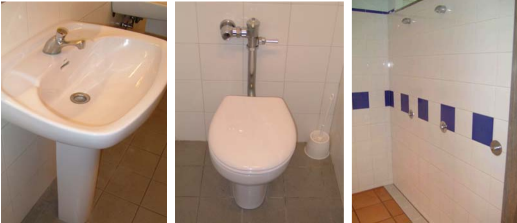
Supervisió visual de l'estat dels elements de fontaneria
