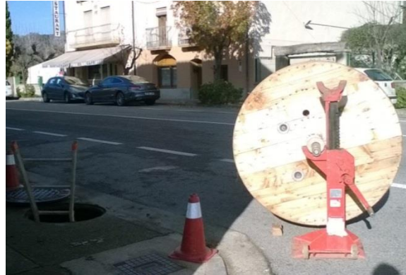
Instal·lació de cablejat
