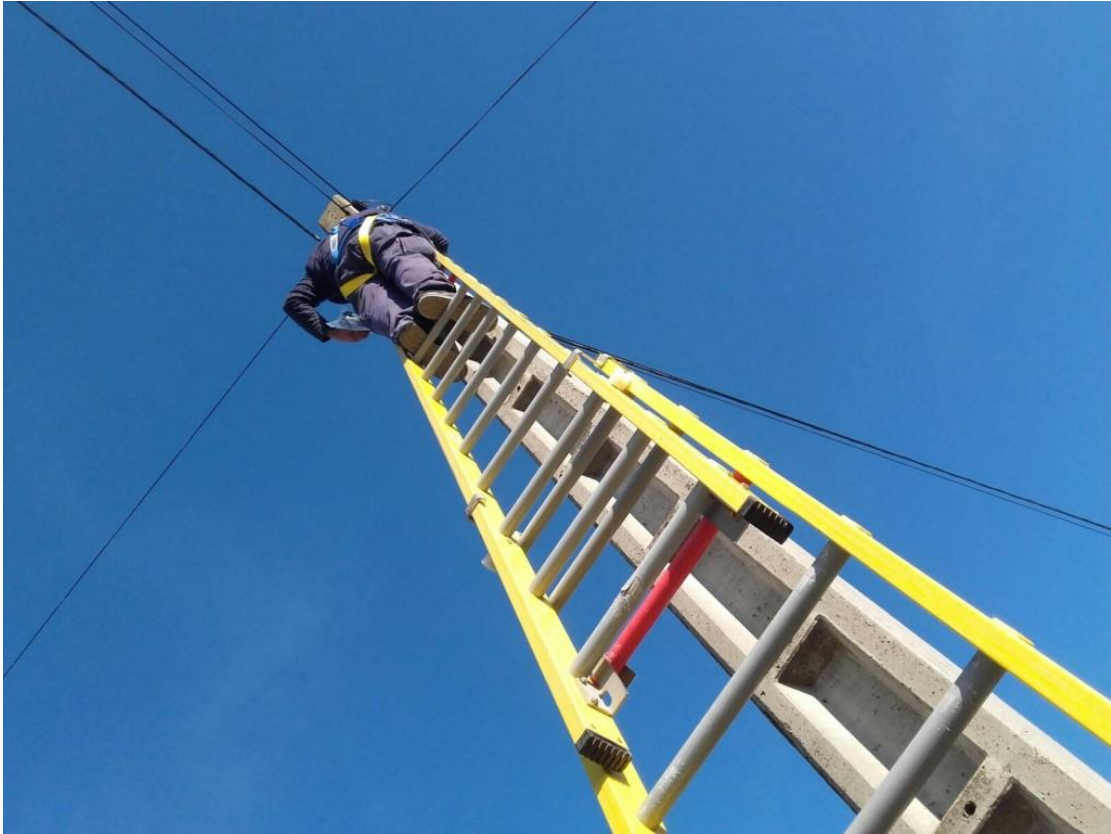
Instal·lació de fibra òptica
