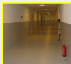
Situat a poca alçada per facilitar detecció
