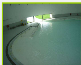
Accés a piscina amb rampa
