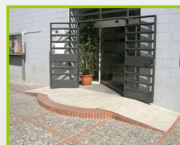
Paviment no lliscant en l'accés
