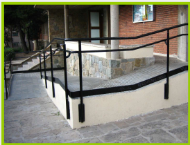
Replans en rampes amb canvi de direcció
