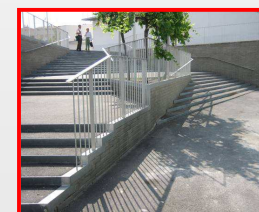
Escala d'A > 2.4 m sense passamà intermedi
