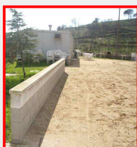
Paviment que no dificulta moviments
