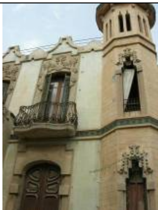
Torre modernista catalogada
