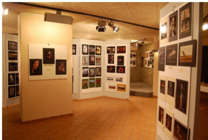
Riel electrificat amb diferents lluminàries a Súria
