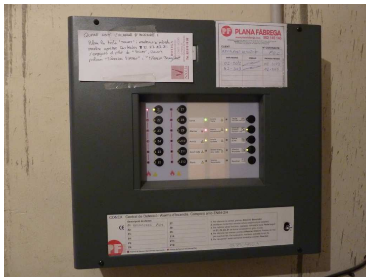
Centralita de detecció d'incendis corresponent a la zona bar
