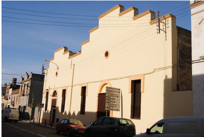
Vista façana avinguda Catalunya
