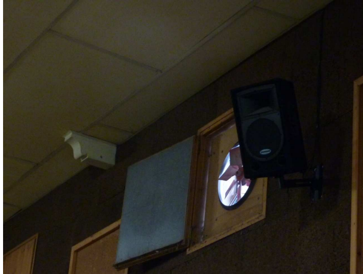
Ventiladors axials situats en façana
